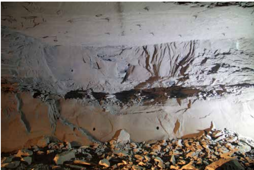
Reaktor po robotach strzałowych.
